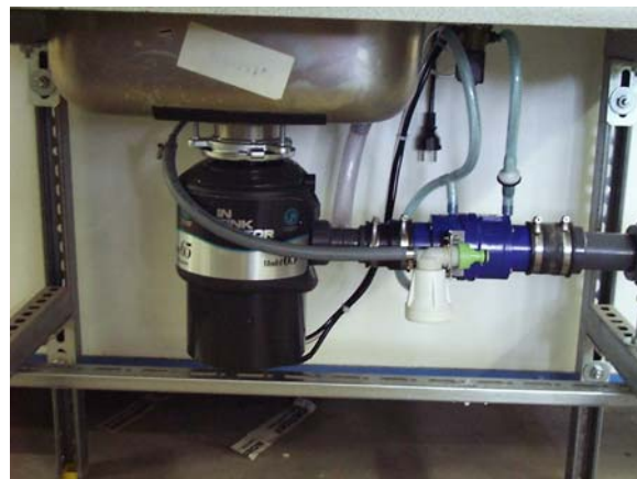
Figuur 8. Verkleiner voor organisch keukenafval (foto: Insinkerator ) met aansluiting op een vacuümrioleringssysteem (foto: Roediger )
